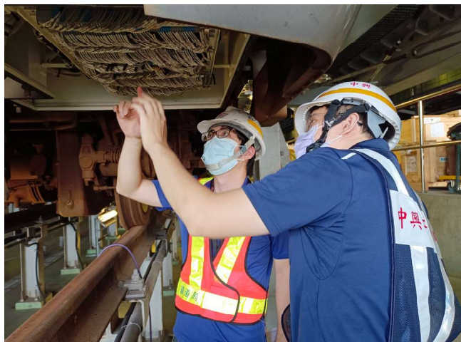
▲號誌系統車載設備檢視作業。(左)
