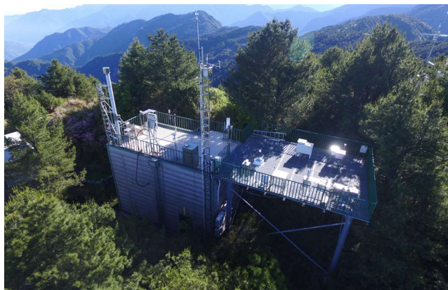
▲ 鹿林山國際大氣背景監測站。
