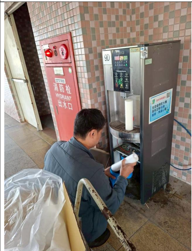
9D 中柱樓 9樓
