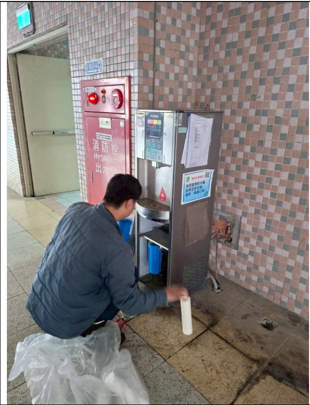
7D 中柱樓 7樓
