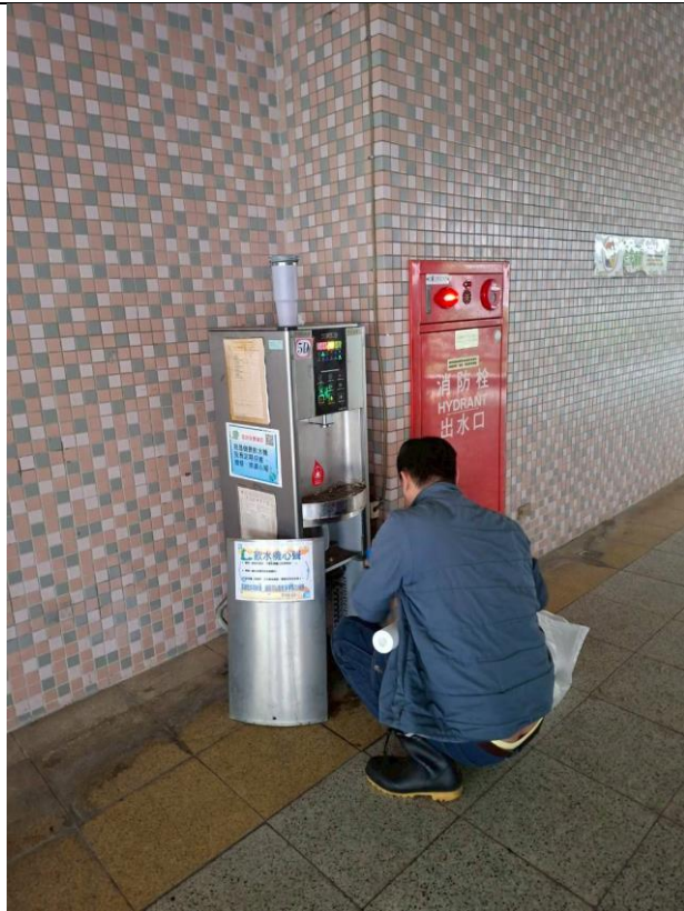
5D 中柱樓 5 樓
