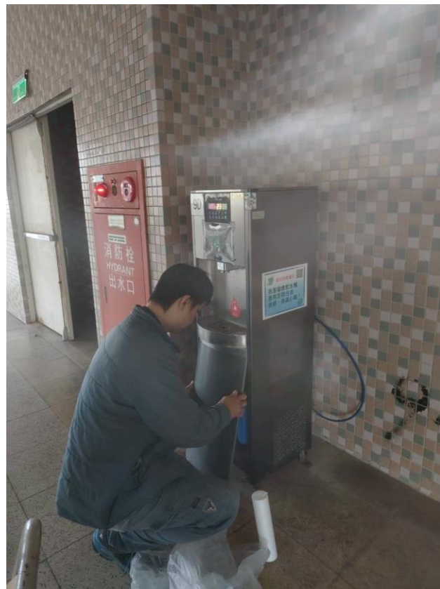
9D：中柱樓 9樓
