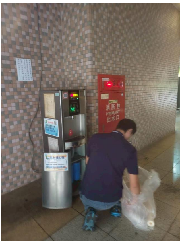
4D：中柱樓 4 樓
