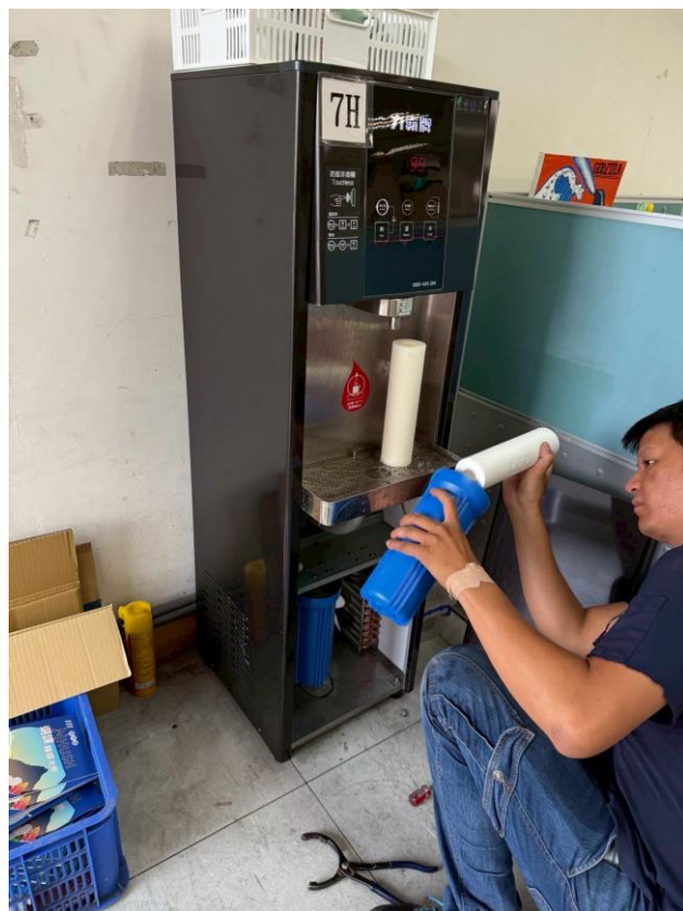
7H：7 樓輔導室 02
