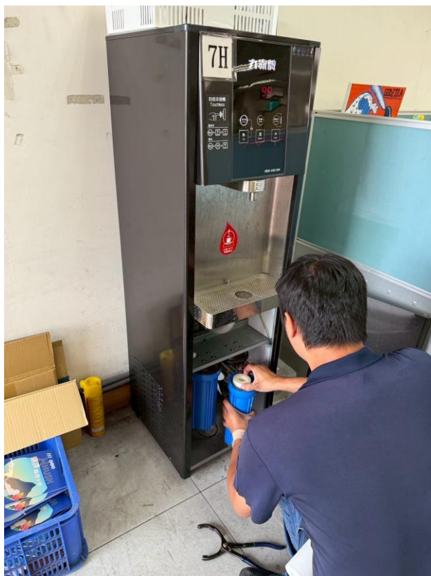
7H：7 樓輔導室 01
