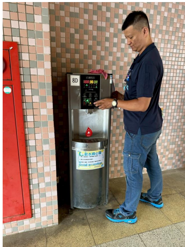
8D：中柱樓 8 樓 02
