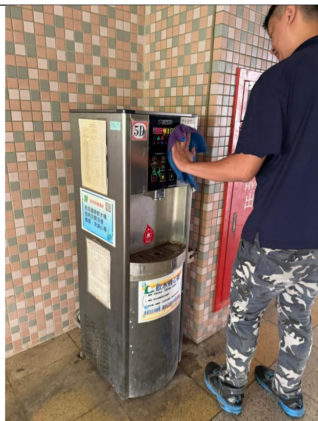
5D：中柱樓 5 樓 01
