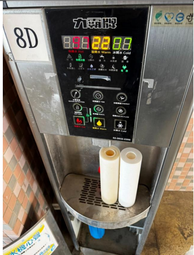
8D：中柱樓 8 樓
