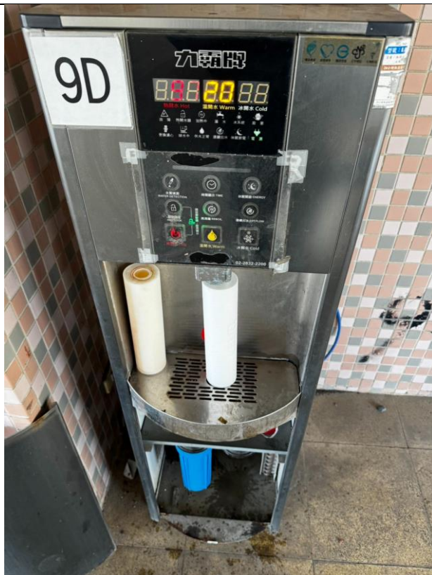
9D：中柱樓 9 樓
