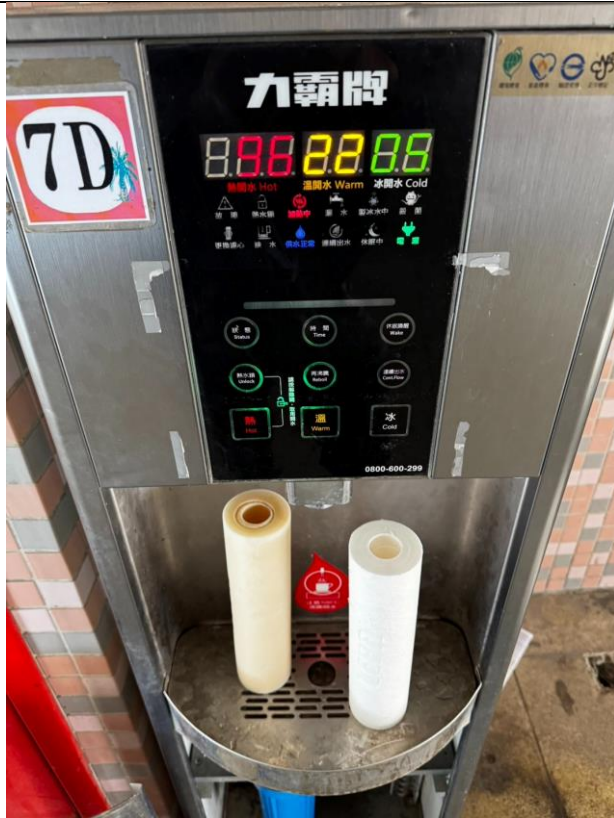
7D：中柱樓 7 樓
