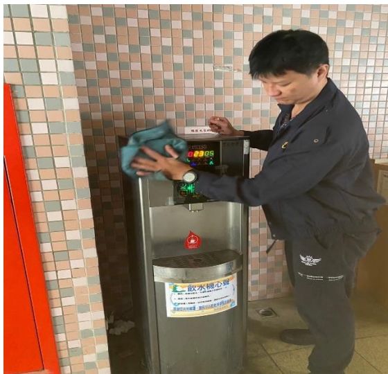
6D:中柱樓6樓
