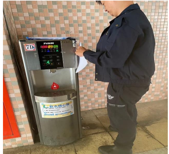
7D:中柱樓7樓
