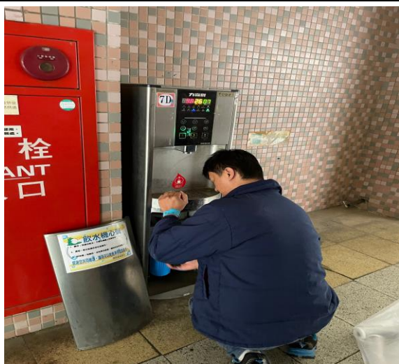
7D：中柱樓 7 樓 01
