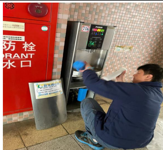
7D：中柱樓 7 樓 02
