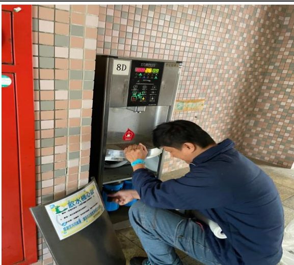
8D：中柱樓 8 樓 01
