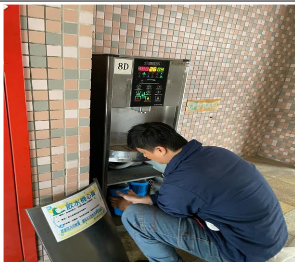
8D：中柱樓 8 樓 02
