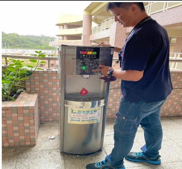
7B：東風樓北側 7 樓 01
