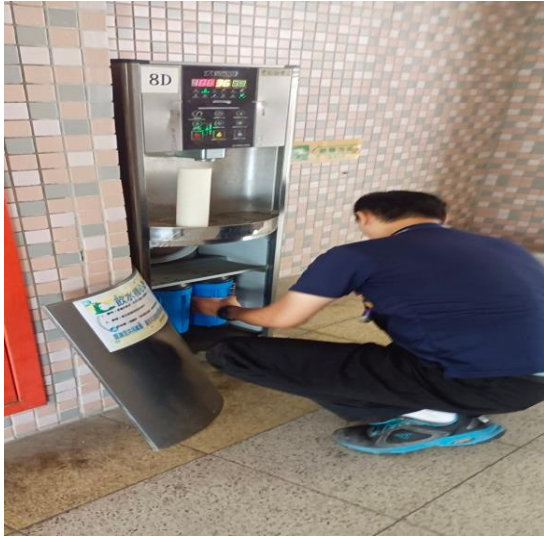
8D: 中柱樓8樓
