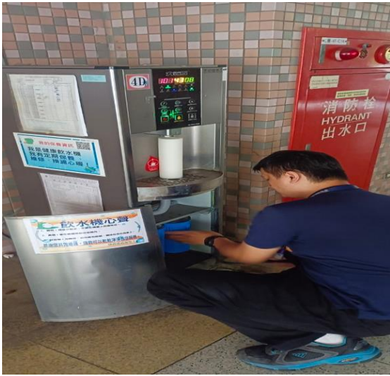
4D: 中柱樓4樓
