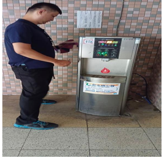
4D: 中柱樓4樓
