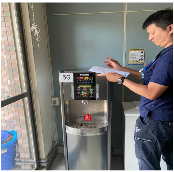
5G: 5樓導師室
