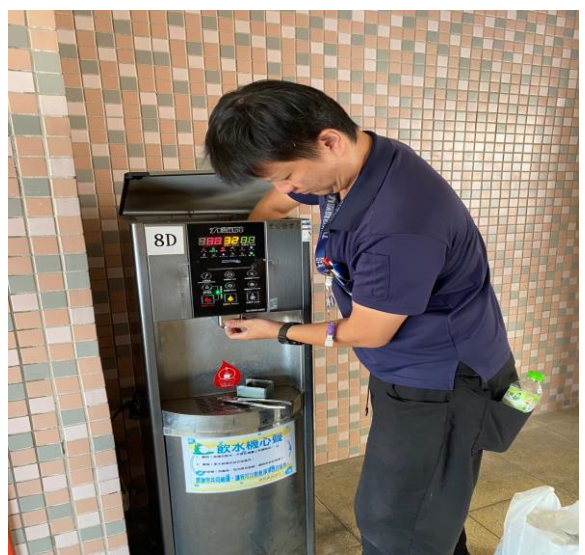
8D：中柱樓8樓
