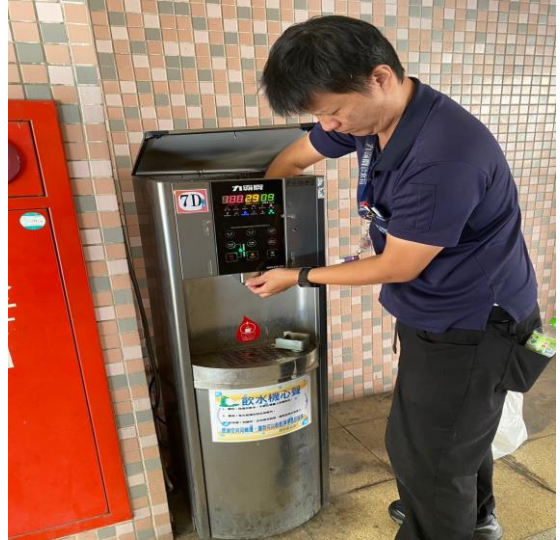
7D：中柱樓7樓
