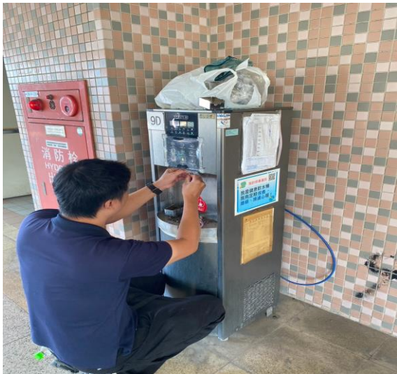
9D：中柱樓9樓
