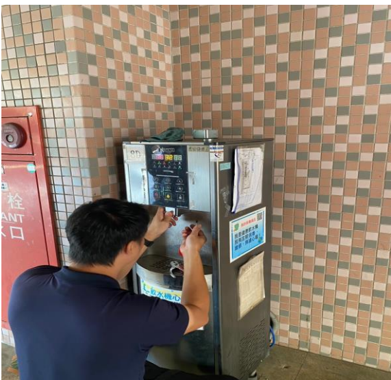
8D：中柱樓8樓
