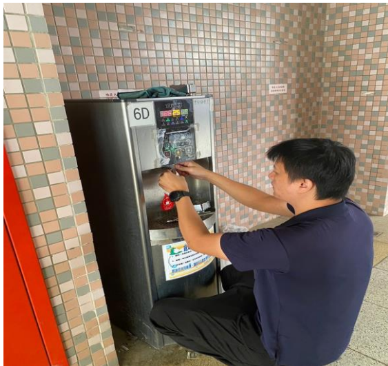
6D：中柱樓6樓
