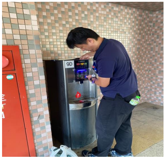
9D：中柱樓9樓
