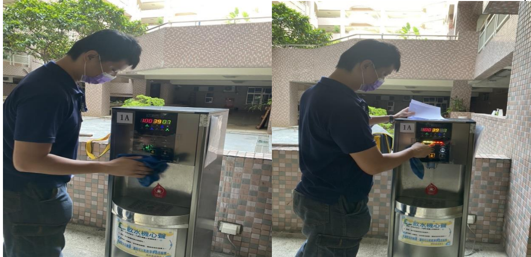
2C:平山樓2樓
