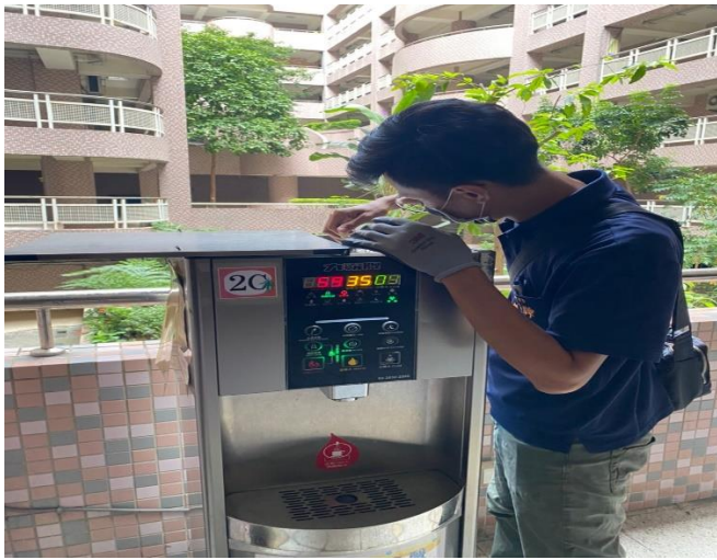
2C:平山樓2樓
