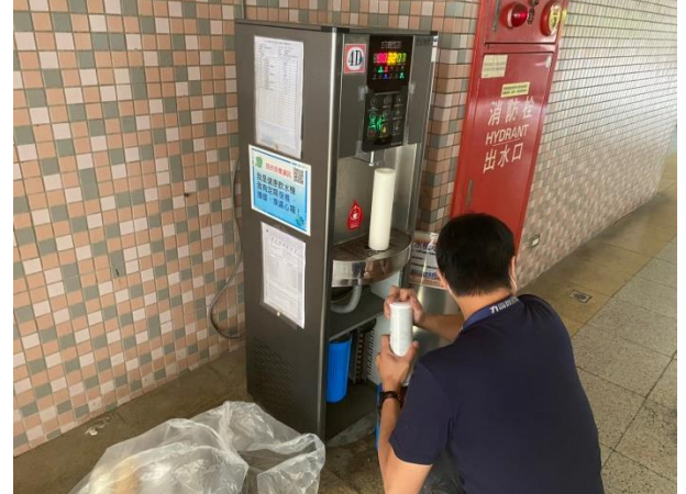
4D：中柱樓 4 樓
