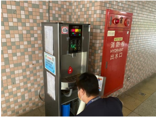
4D：中柱樓 4 樓
